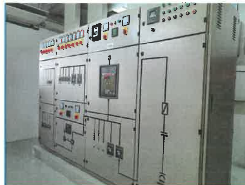
ภาพถ่ายที่ 2.2-7 ตู้ควบคุมระบบไฟฟ้า MDB
